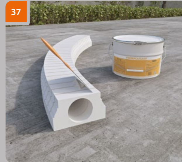
37 Füllen Sie die Schnitte mit Spachtelmasse.
