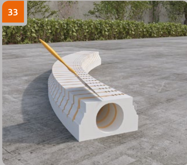
33 Überschüssigen Kleber mit einem Schaber entfernen.
