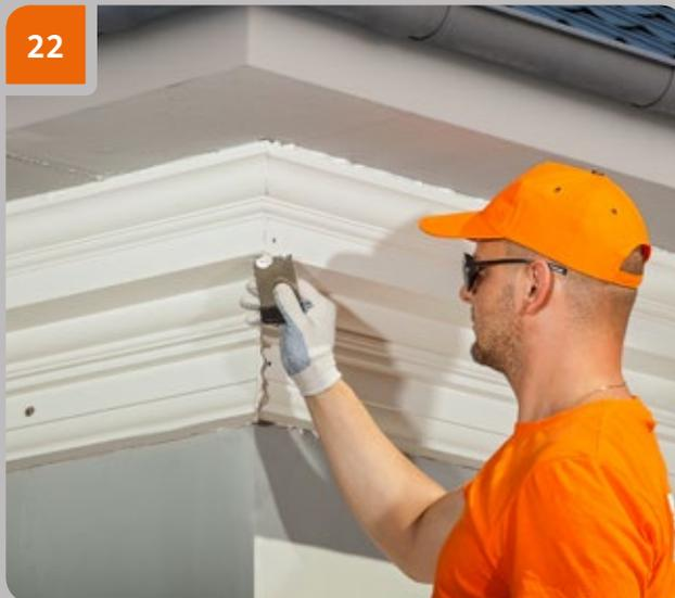
Überschüssigen Kleber sofort nach dem Kleben mit einem Spachtel entfernen.
