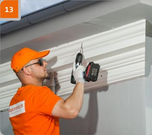
Mit der Schraubpistole und einer Schneidschraube den oberen Teil des Elements ziehen und den oberen Teil der Schraube 2 mm einsenken.
