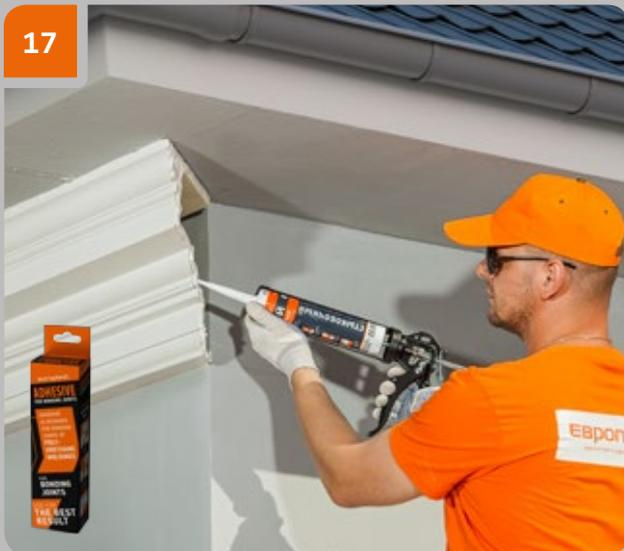
Den «Evroplast for bonding joints» Adhesive auf das freie Ende eines bereits montierten Teils auftragen.
