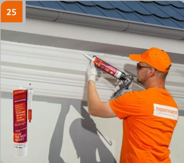
An Stellen, an denen ein Teil an der Oberfläche anliegt und kein Kleber aus der Fuge ausgetreten ist, füllen Sie die Lücken mit mehr Kleber.
