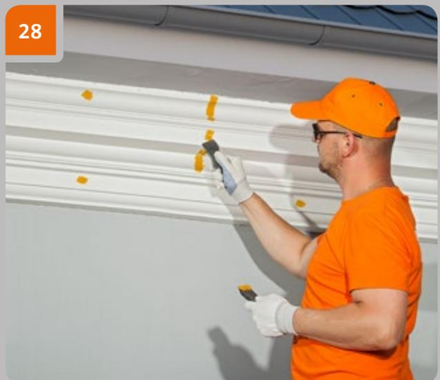
Spachtelmasse auf die behandelten Stellen und über die Schraubenköpfe auftragen — Autospachtel verwenden.
