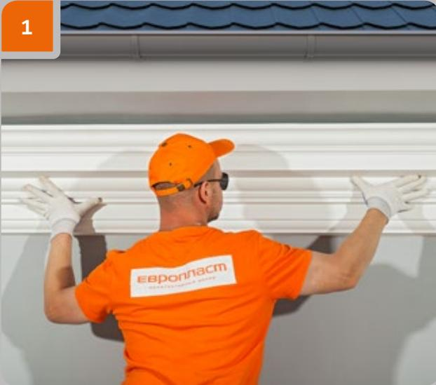
Befestigen Sie das Teil an der Montagestelle. Drücken Sie das Teil fest an Wand und Decke und markieren Sie die Wand entlang der Unterkante des Produkts.
