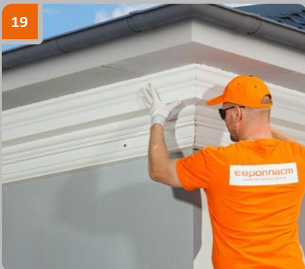
Befestigen Sie das Teil an der Montagestelle. Über die gesamte Länge so fest andrücken, dass Klebstoff aus der Fuge austritt. Schieben Sie das Teil entlang der Wand und drücken Sie es gegen das benachbarte Teil, so dass Klebstoff aus der Fuge austritt.
