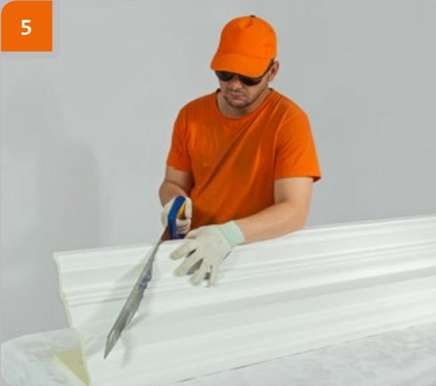
Beenden Sie den Schnitt mit einer Handsäge.
