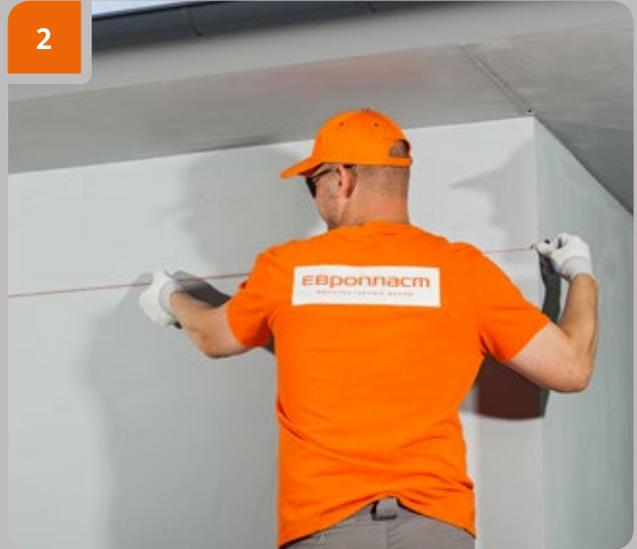
Ziehen Sie eine Linie mit einem Kreidestrich, der die Markierungen verbindet.
