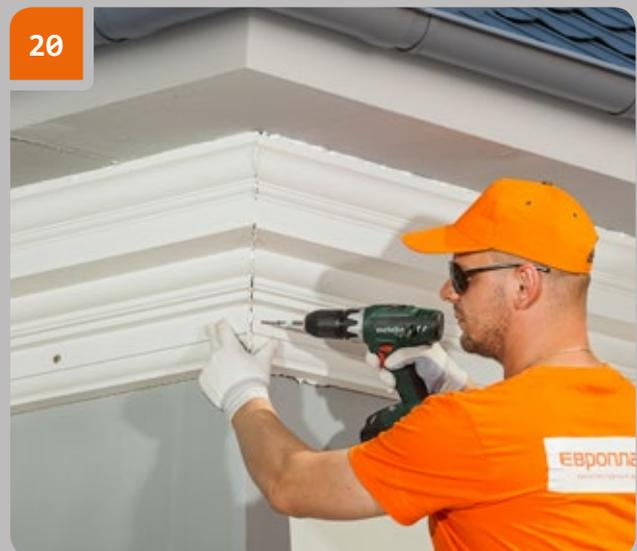
Befestigen Sie das Verbindungsstück mit Schneidschrauben.
