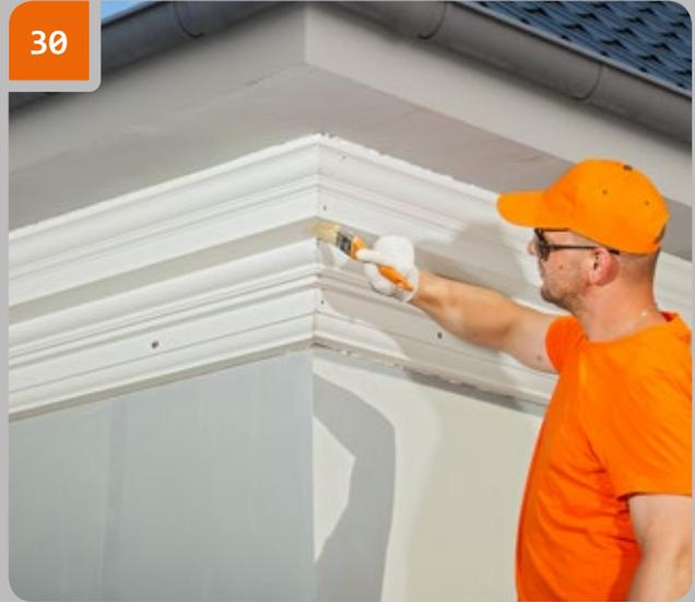
Befolgen Sie die Anweisungen des Farberstellers und streichen Sie die montierten Teile von der Ecke des Gebäudes aus an.
