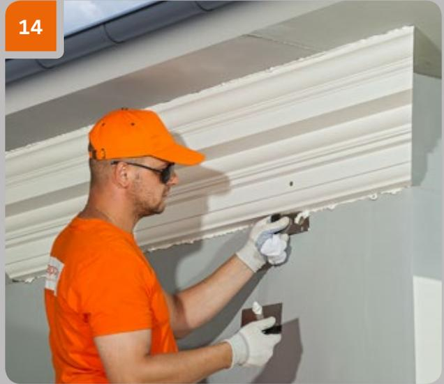
Unmittelbar nach dem Einsetzen der Schneidschrauben, überschüssigen Kleber mit einem Spachtel entfernen.
