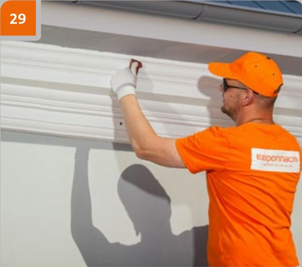
Nach dem Trocknen der Spachtelmasse die behandelten Stellen und die gefüllten Schraubenlöcher mit weichem Schleifpapier polieren. Wiederholen Sie ggf. Schritt 28.
