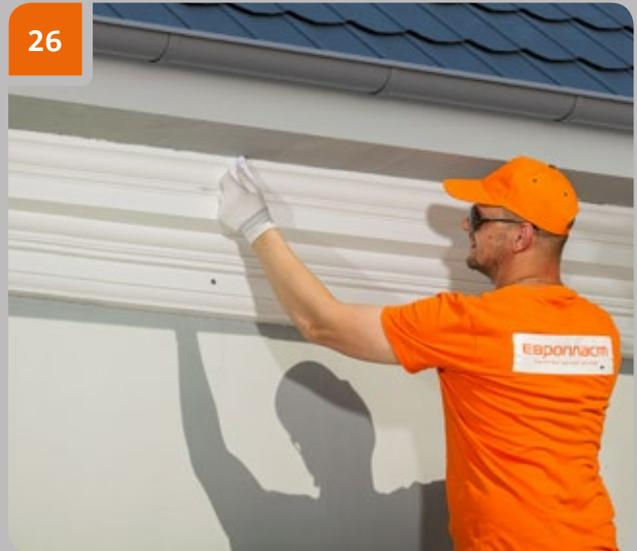
Verwenden Sie Aceton und Tuch, um überschüssigen Klebstoff zu entfernen.
