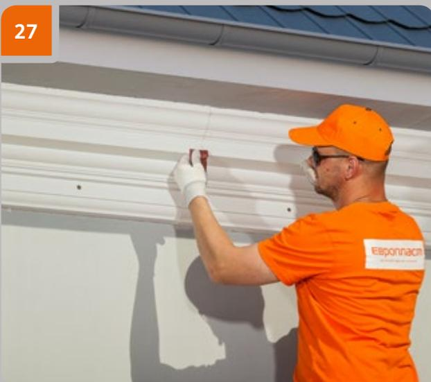
Warten Sie 3 Stunden und glätten Sie die Fugen mit weichem Schleifpapier, damit eine gleichmäßige Oberfläche entsteht.
