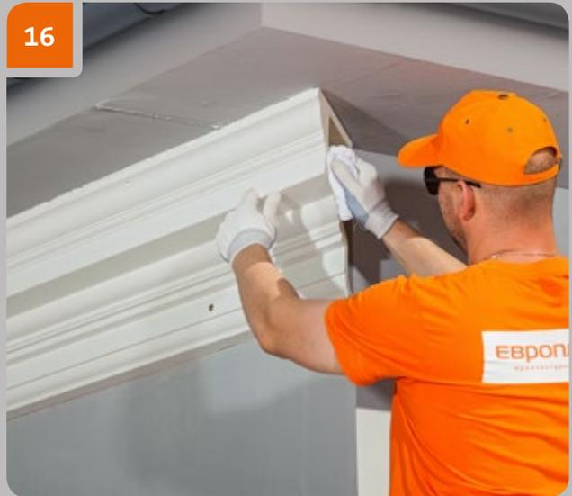
Verwenden Sie ein angefeuchtetes Tuch, um die Stoßenden der angrenzenden Teile von Staub und anderen Verschmutzungen zu reinigen.
