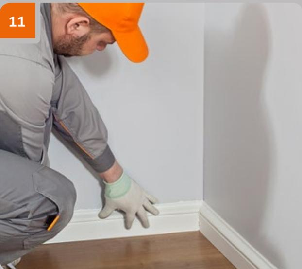
Appuyer le produit sur le mur et le plancher pour que la colle ressorte sur toute la surface. Glisser l'élément le long du mur en appuyant contre l'élément adjacent pour que la colle ressorte du joint.
