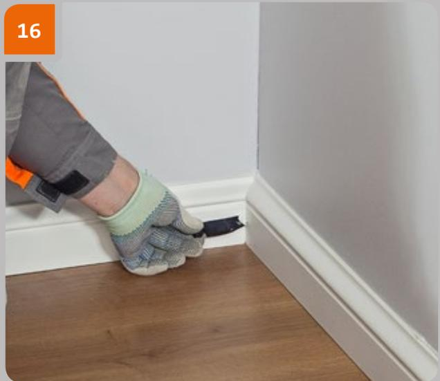
Remplir les joints poncés avec un joint fin soluble à l'eau pour les travaux intérieurs et, le cas échéant, répéter «Etape 20» jusqu'à obtenir une surface plane. Quand le mastic est sec (60 minutes), répéter «Etape 15» si cela est nécessaire.
