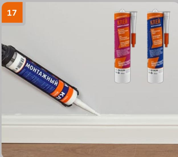
Remplir le joint du produit avec de la colle dans les zones où la colle n'est pas ressortie.
