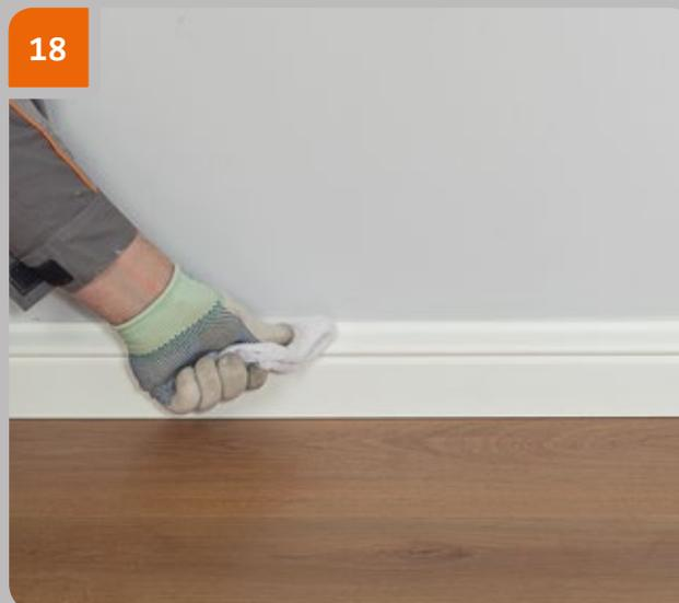
Essuyer l'excès de colle avec un chiffon imbibé d'eau si vous utilisez la colle «Evroplast Mounting» ; avec de l'acétone si c'est de la colle «Evroplast Multipurpose».
