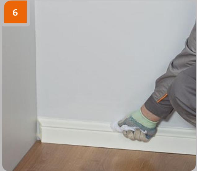
Le cas échéant, essayer la jonction entre le produit et le mur avec un chiffon imbibé d'eau si vous utilisez la colle «Evroplast Mounting» ; avec de l'acétone si c'est de la colle «Evroplast Multipurpose».
