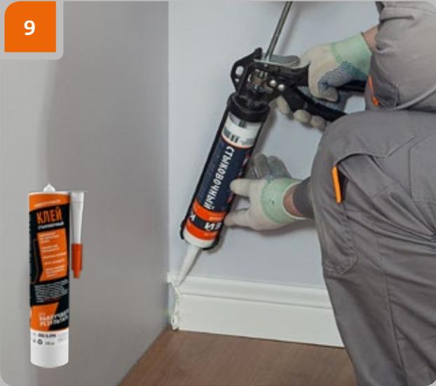
Appliquer de la colle «Evroplast for bonding joints» à l'extrémité du produit à monter.
