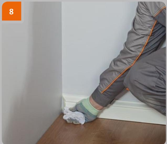
Essuyer les extrémités des produits se joignant avec un chiffon mouillé pour retirer les impuretés.
