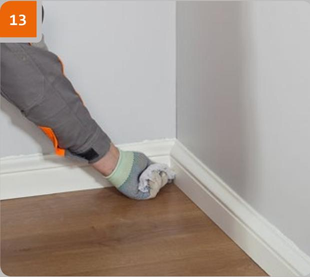
Essuyer la zone du joint avec un chiffon mouillé à l'acétone.
