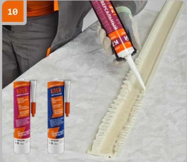
Appliquer de la colle « Evroplast Mounting» ou «Evroplast Multipurpose» sur la surface de montage du produit suivant.
