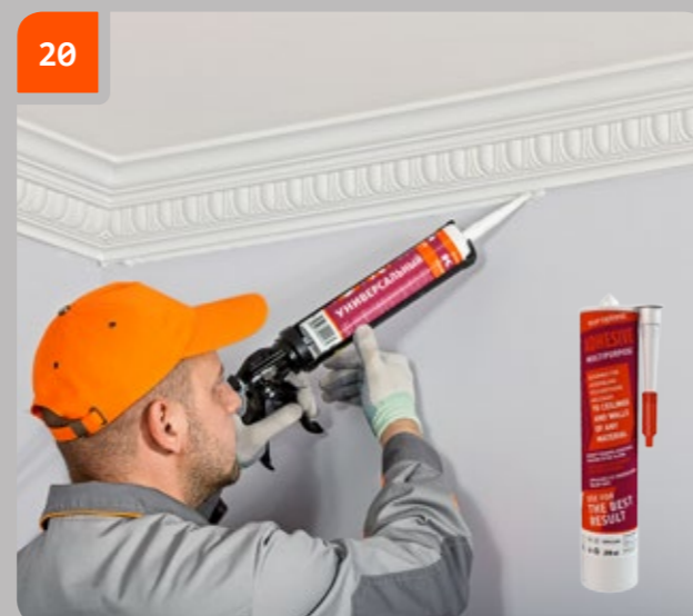
20 Avec de la colle «Evroplast Multipurpose», remplir les espaces du joint entre la corniche et le mur et le plafond où la colle n'est ressortie du joint.
