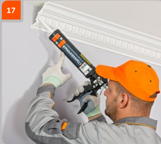
17 Continuer le processus d'installation de la corniche suivante.
