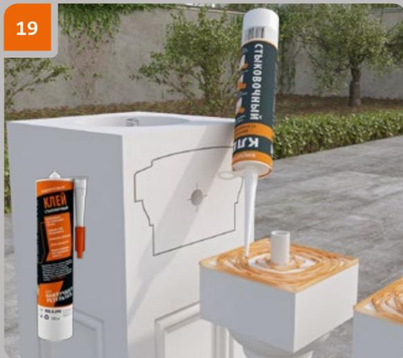
Appliquer de «Evroplast for bonding joints» sur la face supérieure (joignant la rampe) des balustrades.
