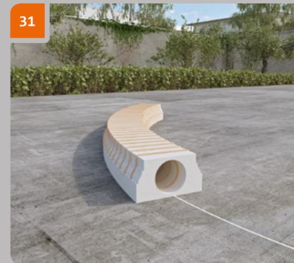
Placer l'élément sur la surface selon les marques de rayon, sécuriser la position de l'élément.
