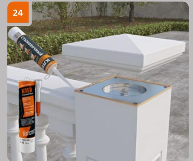
Pour installer un capuchon de colonne, utiliser de «Evroplast for bonding joints».
